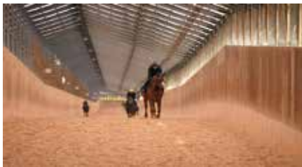
写真1 屋内調教用坂路 勾配0.0～5.5%、高低差21m、走路幅7m、延長900m、帰り馬道幅3mに整備され、コースには20cmの厚さでカラマツのウッドチップが敷き詰められています。
