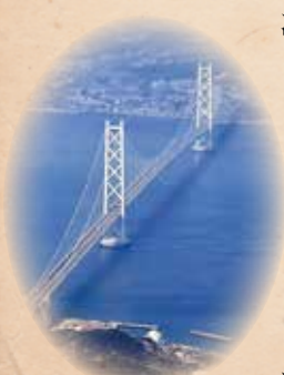
▲明石海峡大橋
