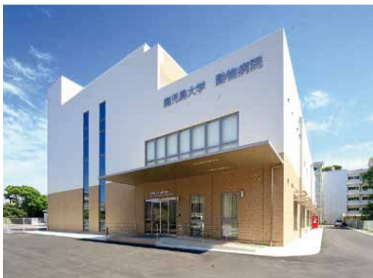
図1 新築した小動物病院の外貌
