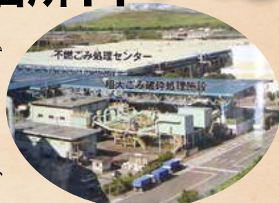
▲不燃物/粗大ゴミの処理施設
