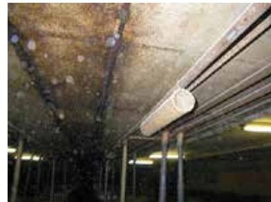
写真2：防研パイプ ネズミの生態を利用した捕獲器で餌なども不要、営巣箇所としてパイプ内で繁殖させ、一気に捕獲する方法です。
