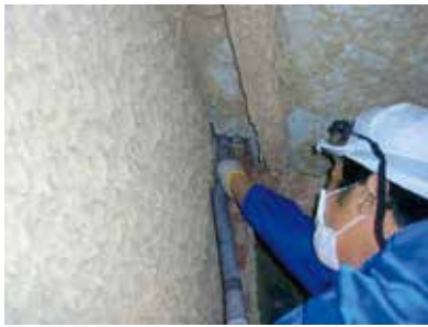
写真5：通り穴の閉鎖
