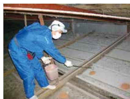
写真7：天井裏への殺鼠剤配置
