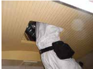
写真5 天井裏を目視で確認
